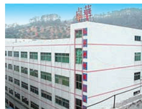
液晶用バックライト製造工場 卓華電子科技（深圳）有限公司外観
